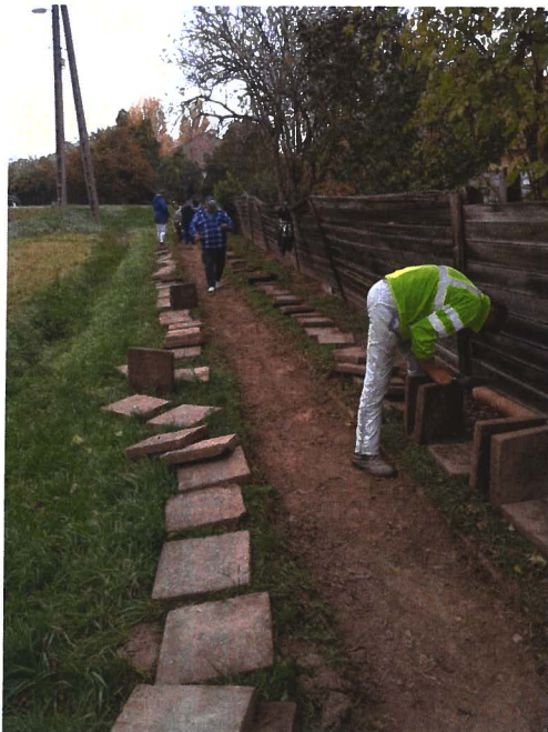
Kép: Raktár utca járdázása, illetve a Kasza utca – Bocskai utca sarkán monolit beton feltörése, tükrökészítés, járdalapok lerakása
