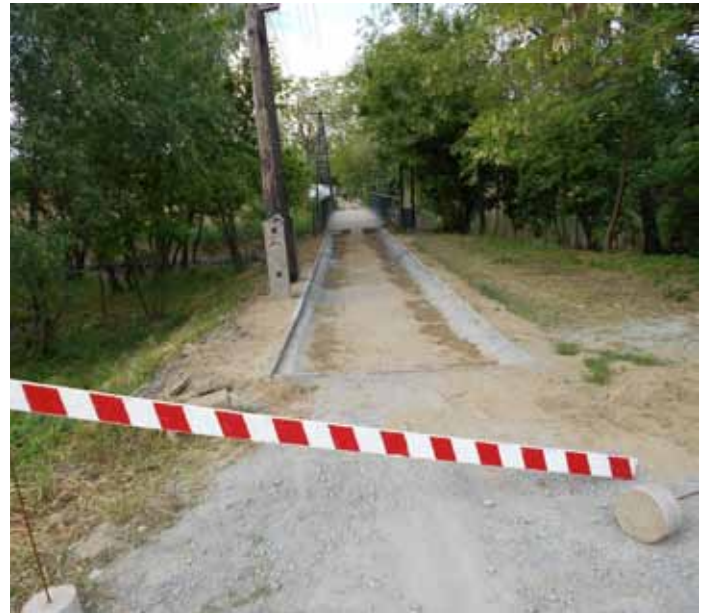
A Jámbor utcai híd felújítása zajlik.
